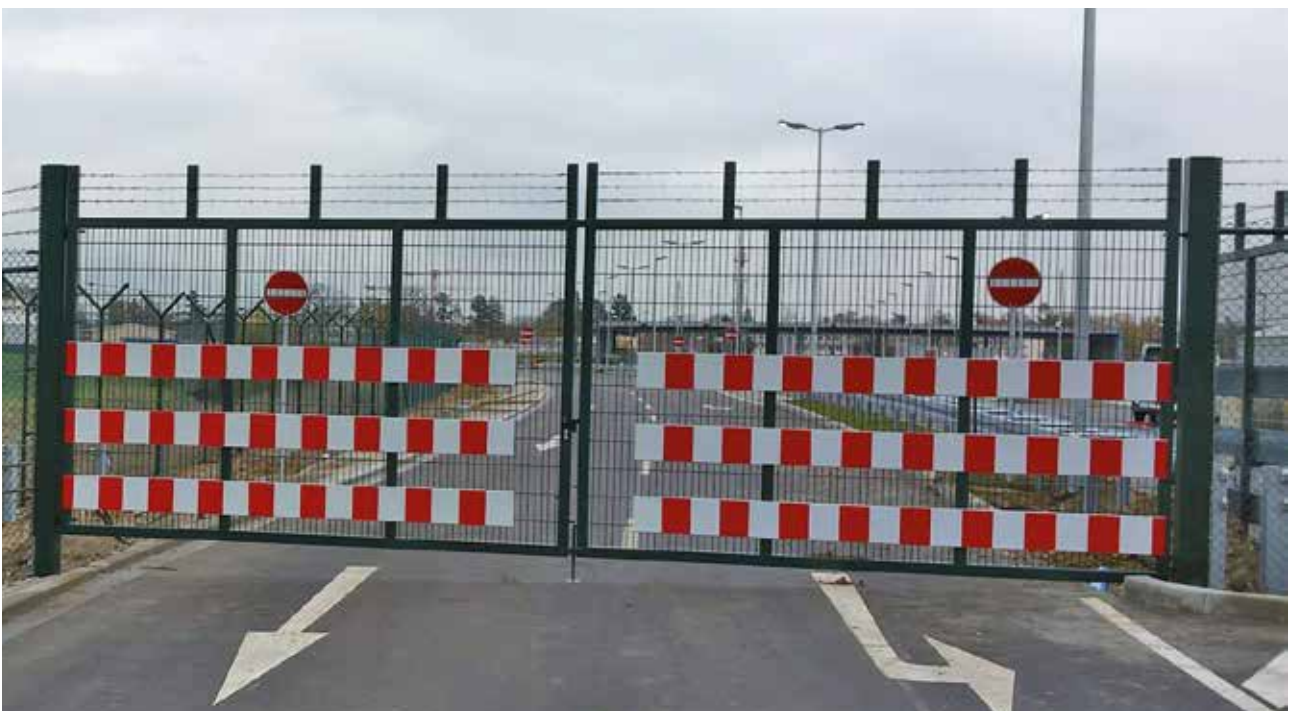
Drehflügel 2-flügelig, mit Doppelstabfüllung, moosgrün pulverbeschichtet
