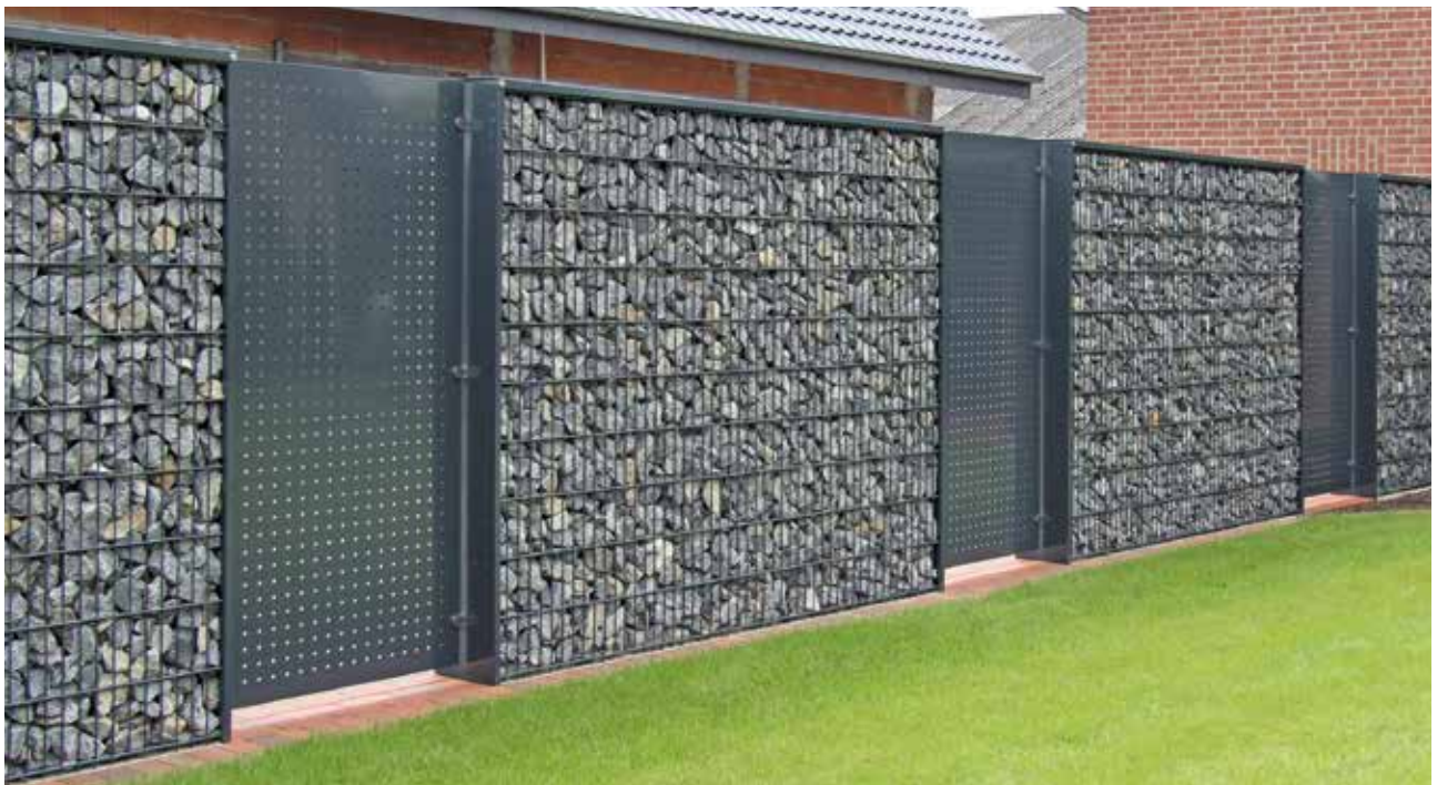
Gabionen in Kombination mit Lochblech-Elementen, anthrazit pulverbeschichtet
