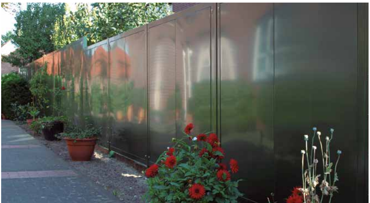
Kassetten-Sichtschutz, beidseitig, Pfosten, Rahmen und Blechfüllung moosgrün pulverbeschichtet
