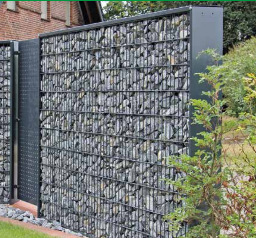
Gabionen in Kombination mit Lochblech-Elementen, anthrazit pulverbeschichtet
