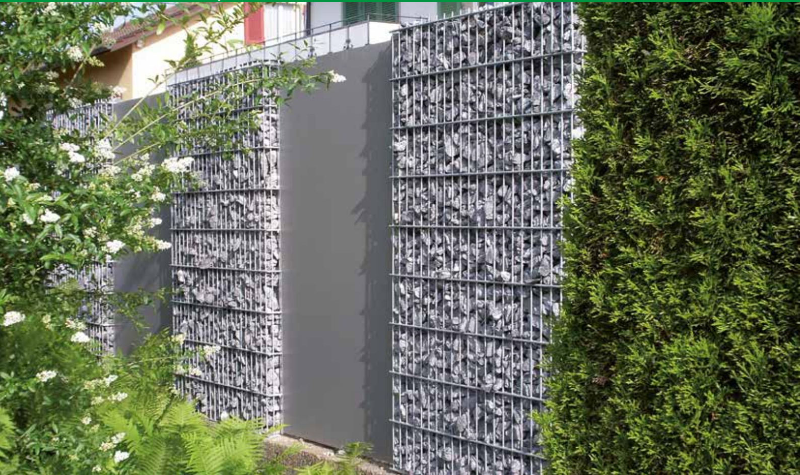
Gabionen-Körbe, komplett verzinkt in Kombination mit Glattblech-Elementen, anthrazit pulverbeschichtet
