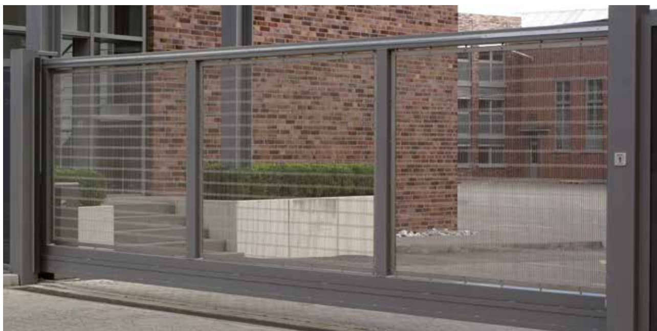
Schiebetor mit Edelstahlgewebe
