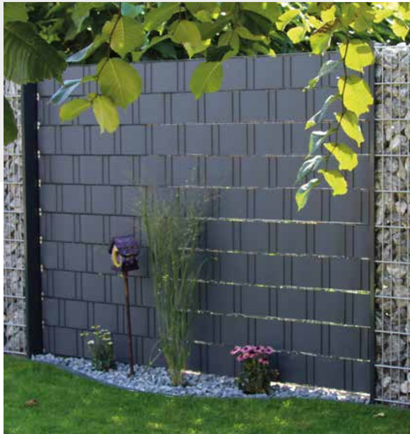
Doppelstabzaun mit Sichtschutzstreifen in anthrazit in Kombination mit Gabionen
