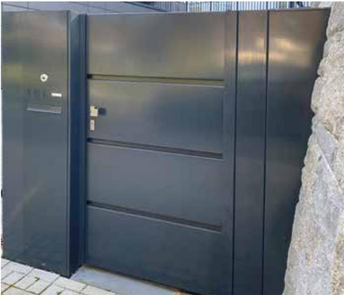
Tor mit Kassettenblechfüllung und waagerechter Sicke
