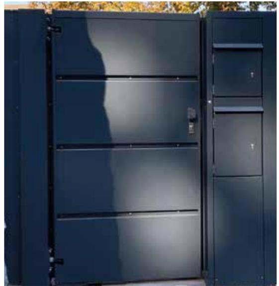
Tor mit Kassettenblechfüllung und waagerechter Sicke
