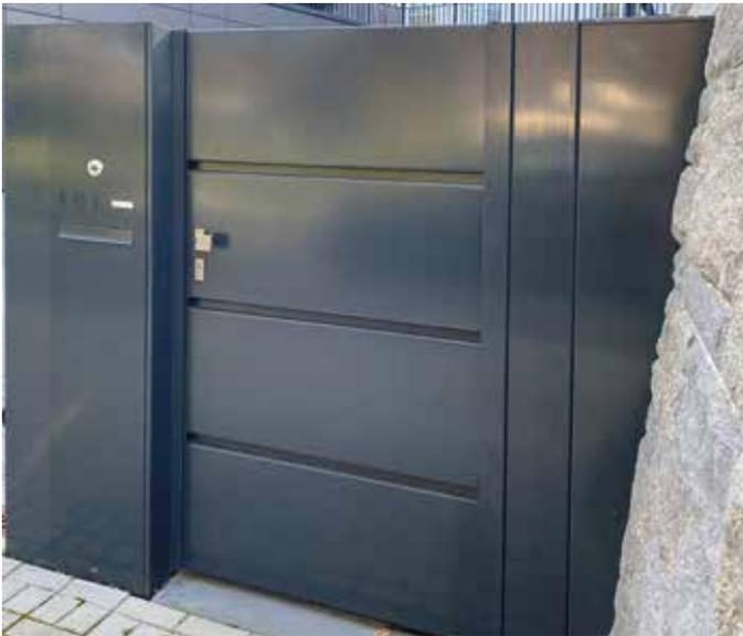
Tor mit Kassettenblechfüllung und waagerechter Sicke
