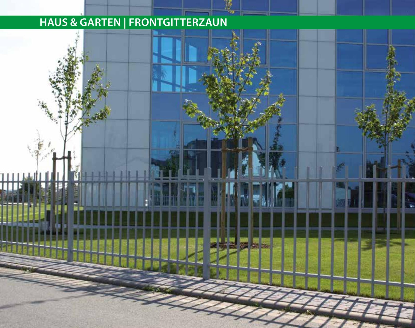
Modell Rhein leicht mit Rundrohr-Füllstäben, steingrau pulverbeschichtet
