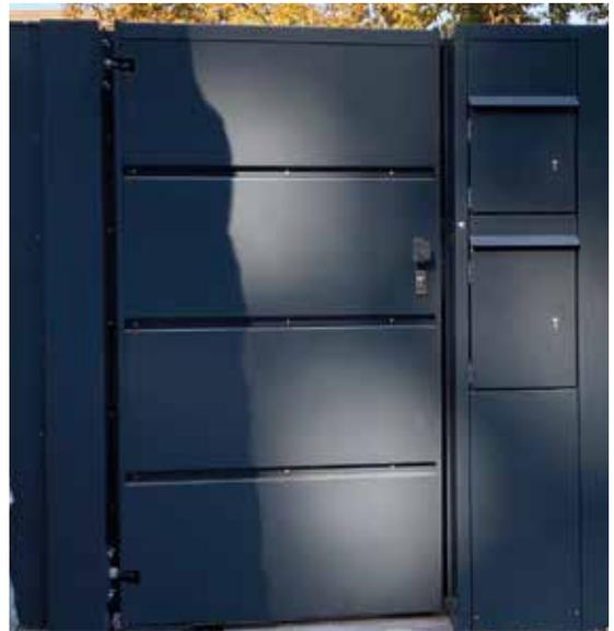
Tor mit Kassettenblechfüllung und waagerechter Sicke
