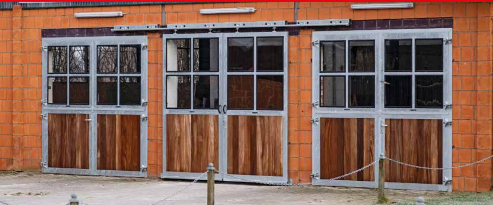
Growi® Stalltor rechts und links: Stalltor 4-teilig mit Sprossenfenster, Füllung Denya-Holzfüllung, Tor mittig: Stallschiebetor, 2-teilig, mit Denya-Holzfüllung, Besonderheit: beide Flügel des mittigen Tores, lassen sich vor die Stalltore vorher schieben (jeweils 1 Flügel nach rechts, ein Flügel nach links)
