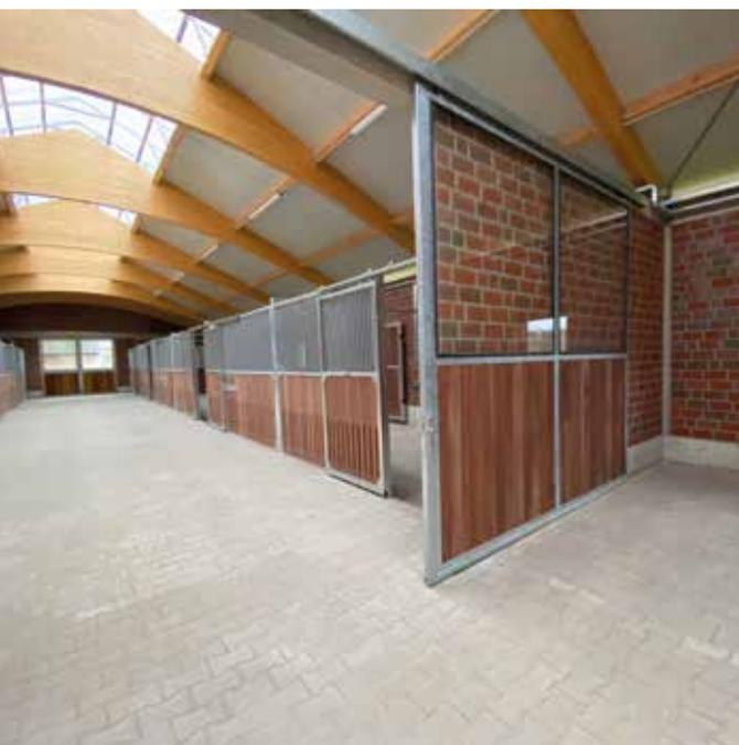
Stallschiebetor mit ESG-Glas, Holzfüllung Bongossi
