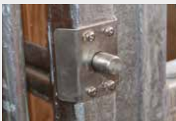
Neu bei uns: In den Frontwänden Nabila, Dolana und Nando bauen wir unsere neuen Edelstahl-Druckknopfverschlüsse ein.
