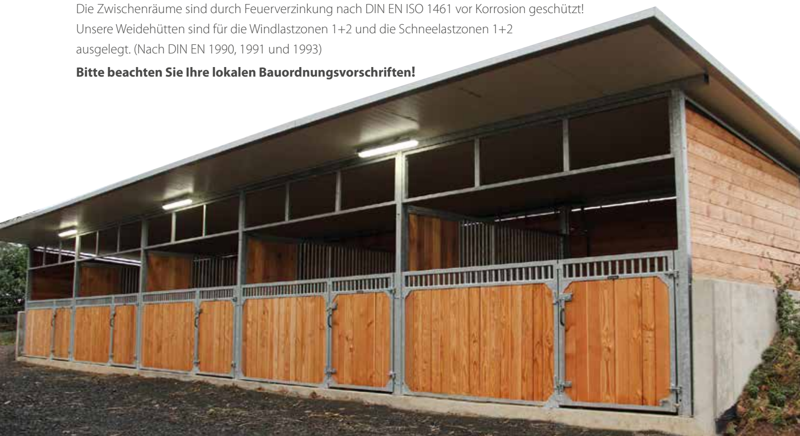
Weidehütte als Außenstall 3500 T mm x 14000 B; Frontwand Cintaro, Trennwand Dakota, mit Iso-Dach
