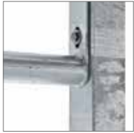
3. Senkrecht Flacheisen direkt verschraubt.
