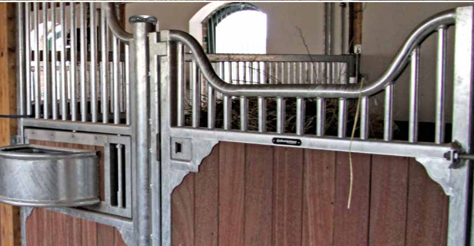
Frontwand Buchela, Holzfüllung Bongossi und Drehtrogvorrichtung
