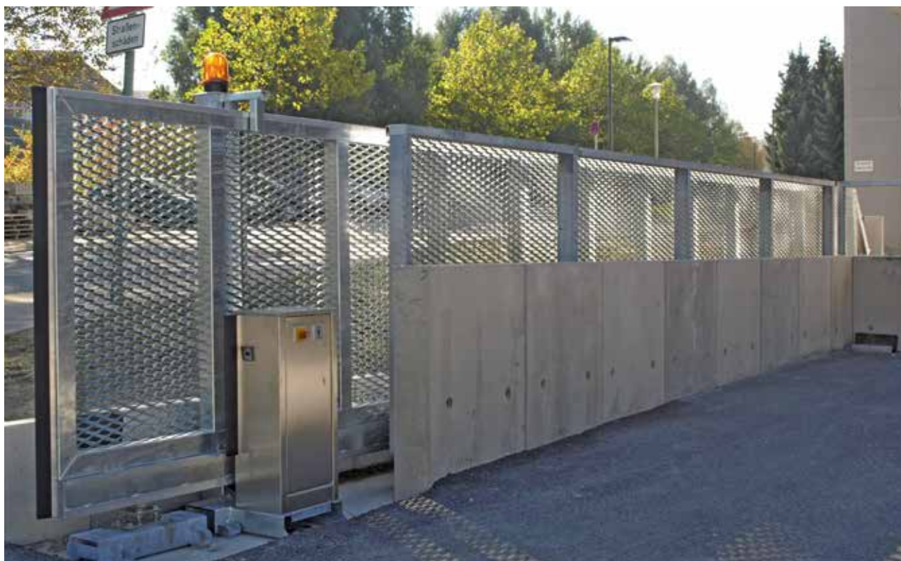
Schiebetor mit Streckmetallfüllung
