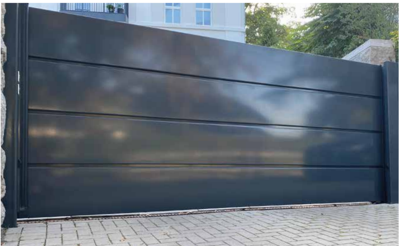
Schiebetor mit Kassettenblechfüllung und waagerechter beidseitiger Sicke
